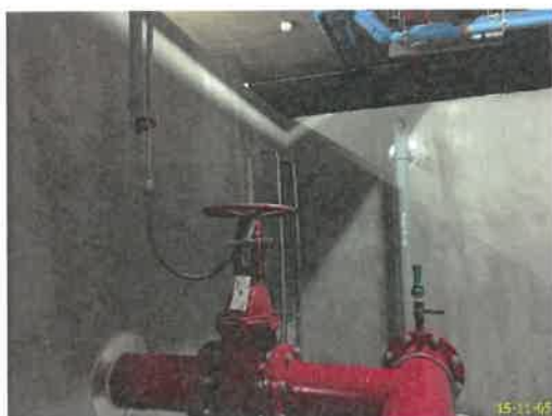
ระบบน้ำสำรองดับเพลิง และระบบจ่ายน้ำดับเพลิง ระบบป้องกันเพลิงไหม้ ภาพที่ 1.3.9-1 (ต่อ) ระบบป้องกันและเตือนอัคคีภัย
