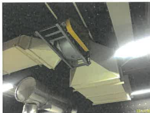
ห้องเครื่อง การระบายอากาศโดยวิธีกล ภาพที่ 1.3.10-1 (ต่อ) ระบบระบายอากาศ
