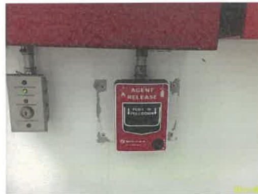
ปุ่มกดแจ้งสัญญาณอัคคีภัย และอุปกรณ์ส่งเสียงสัญญาณแจ้งเหตุ (ต่อ) ระบบตรวจสอบและแจ้งเหตุเพลิงไหม้ (ต่อ)
